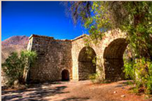
Acueducto de Amolanas (Región de Atacama)
